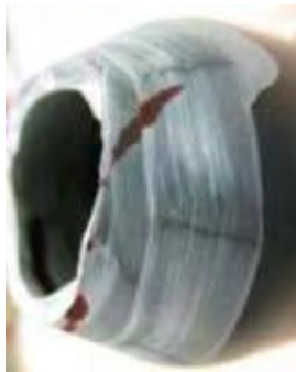
ノズル破損後の燃焼器 (浸透探傷検査の結果のノズル破損で 貫通クラックの存在確認)
