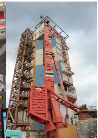
M整備塔改修
