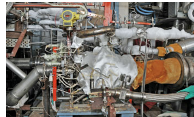
CE20統合ターボポンプ試験状況
