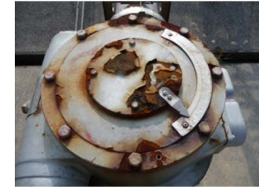
バルブの腐食
